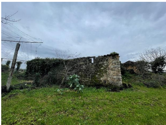
Imagem 1 – Foto onde é visível o colapso da cobertura e a edificação coberta pela vegetação.
